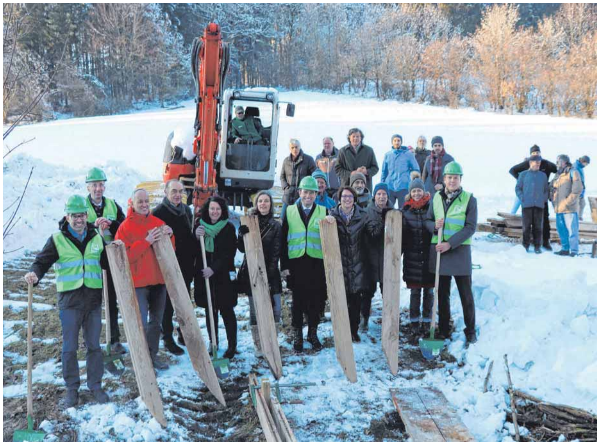
Pfähle wie diese sollen helfen, den Nieratzer Bach als Zufluss zum Schlauchenweiher anzustauen. Am Montag war dazu und zum Modellprojekt Biotopverbund im Landkreis Ravensburg offizieller Spatenstich mit zahlreichen Gästen.
