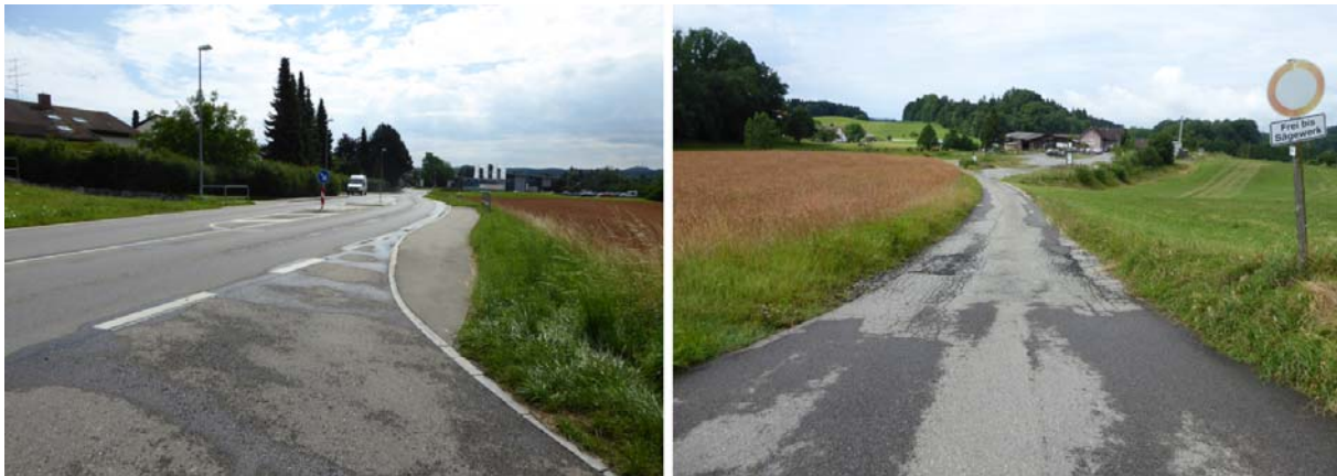
Abbildung: Landesstraße L 317, bestehende Querungshilfe und Werkszufahrt
