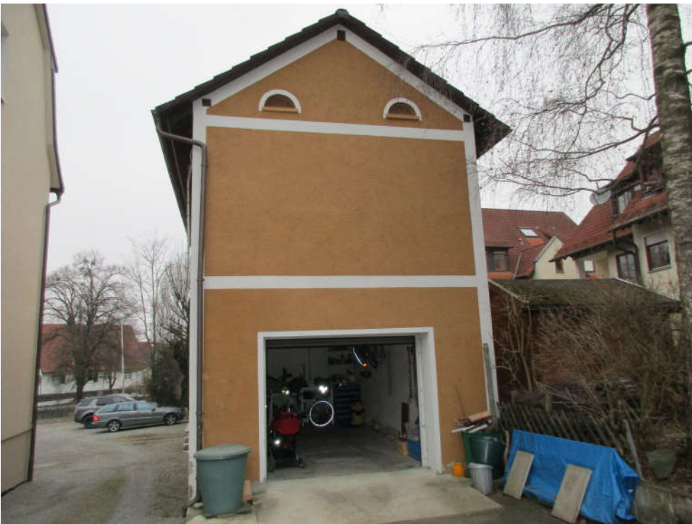
Abbildung 3: Garage Ostseite des Nebengebäudes
