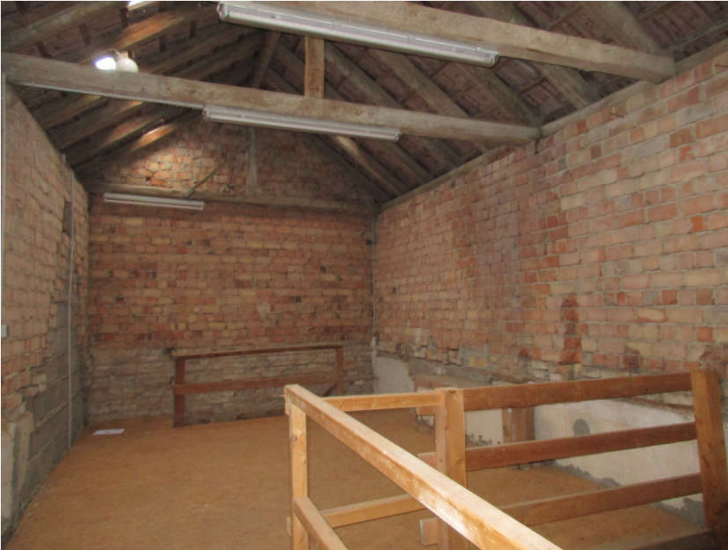
Abbildung 4: Dachboden des Nebengebäudes
